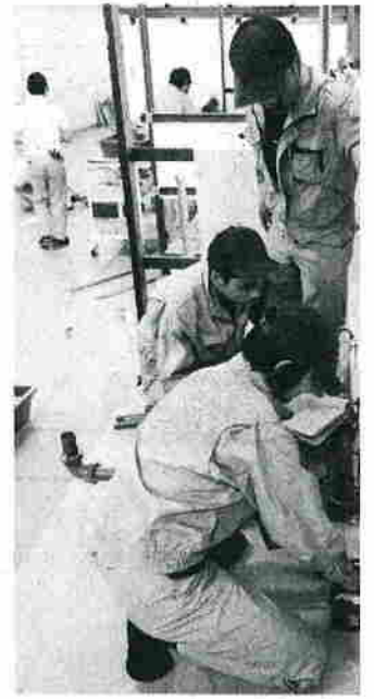
都立城東職業能力開発センターで、配管の取り付け作業をする職業訓練中の女性(手前)ら。8月、東京都足立区
